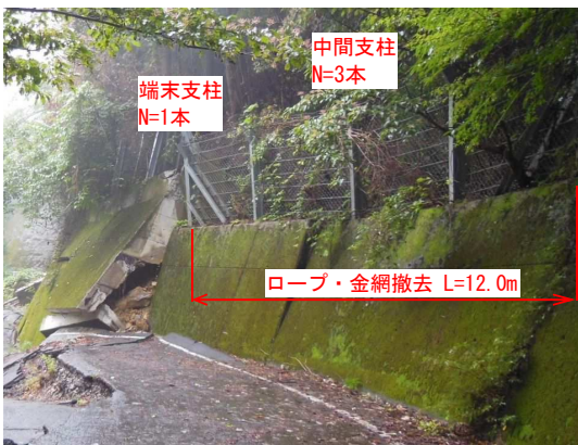
落石防護柵撤去工現況写真
